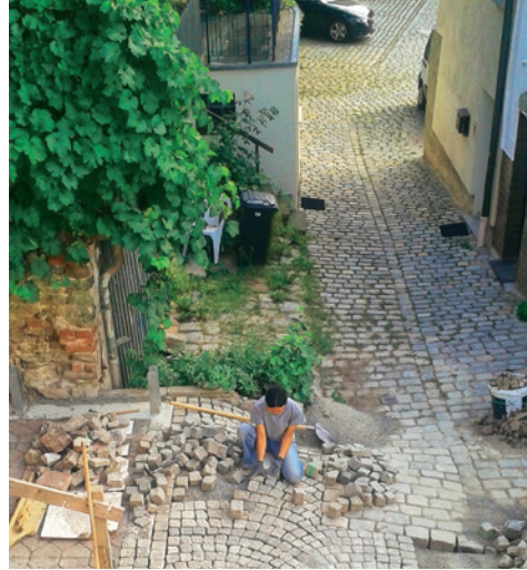
Zufahrt Yuko Karkat-Shimbara beim Pflastern des Hofes. Im Hintergrund die 2,20 Meter schmale Stelle, an der viele Baustellenfahrzeuge bei der Zufahrt gescheitert sind.
