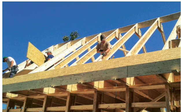
Zupacken Viele Ausbaurbeiten wurden von den Bauherren selbst übernommen – auch bei Kälte mitten im Winter.
